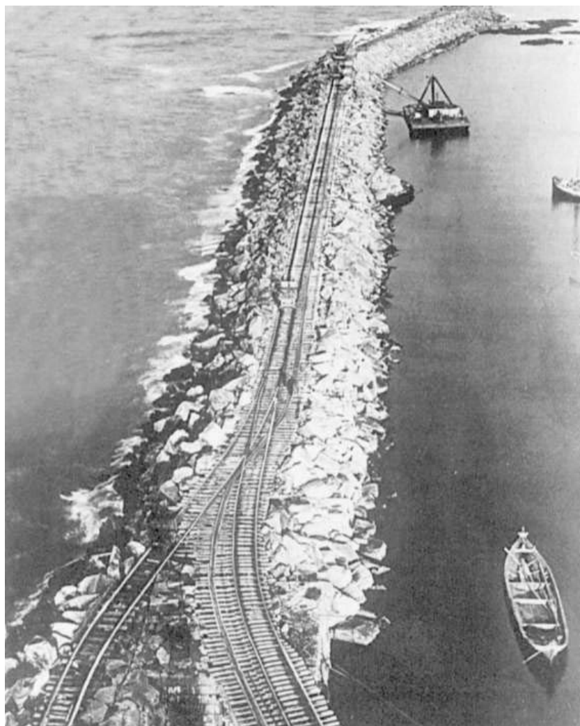
Skinnegangen sett fra toppen av fyret. Her ser man at den deler seg og gikk i sin tid langs bygningene som rommer kulturkontoret og den som rommer blant annet "Hisnakul". Foto utlånt fra fotosamlingen på Bleik. (Klikk for større bilde).
